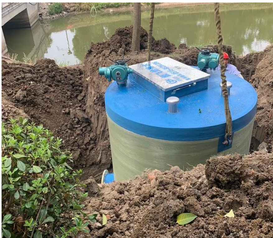
图 5.3.2-9 截污井施工示意图
