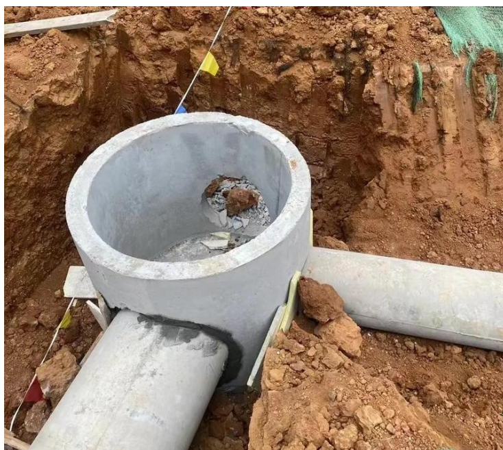
图 5.3.2-8 污水检查井施工示意图
