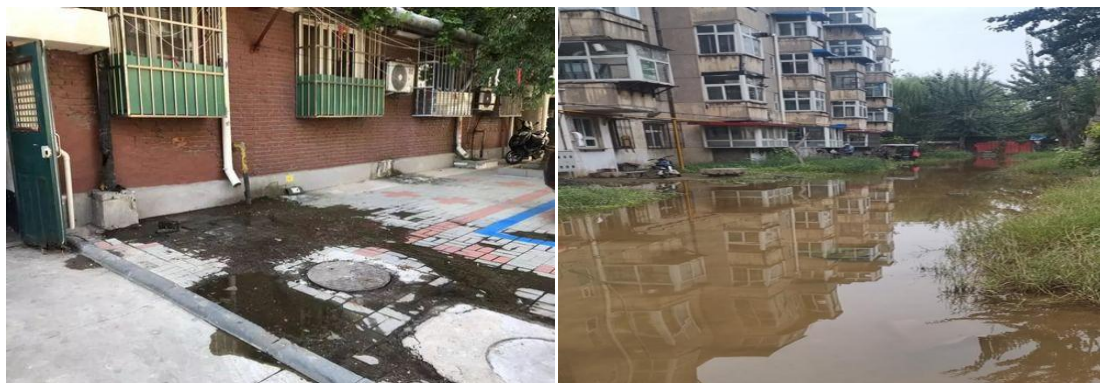
项目范围内排水现状
