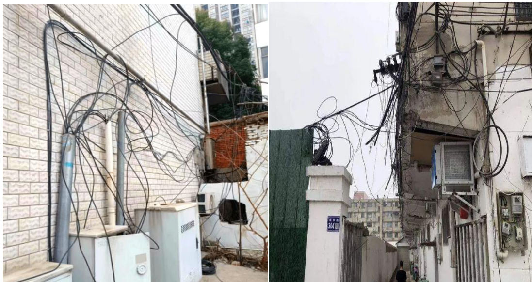
项目范围内电力线路、弱电、照明现状
