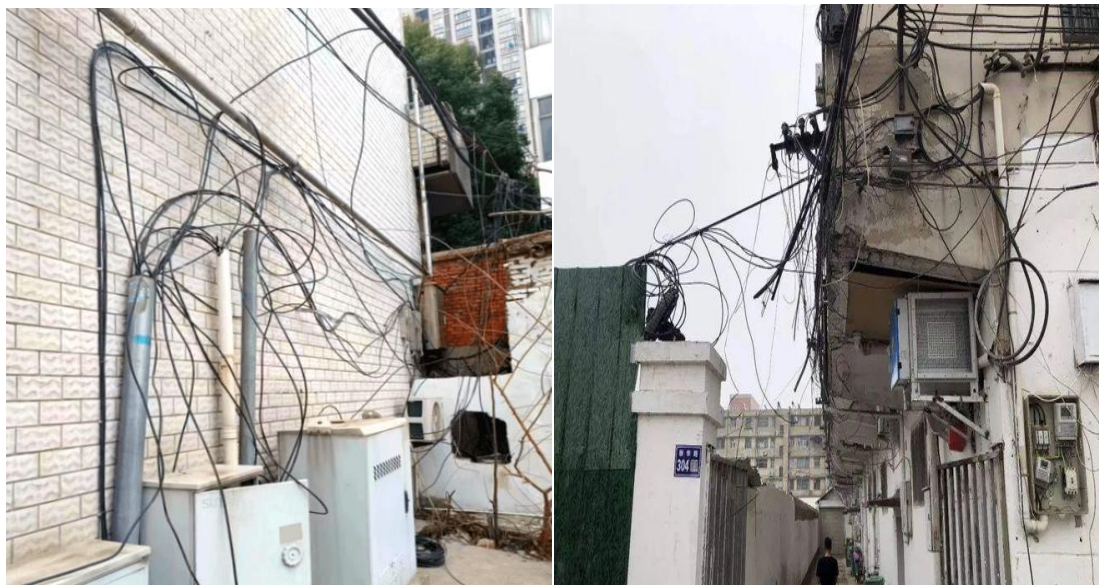
项目范围内电力线路、弱电、照明现状
