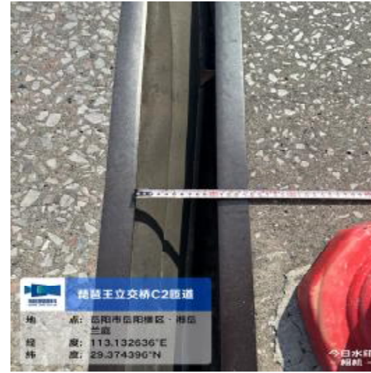
图 2-21 C2匝道桥1#墩伸缩缝处缝宽异常
