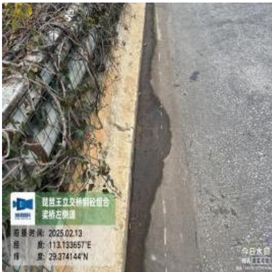
图 2-28 钢砼组合梁桥桥面泄水孔堵塞
