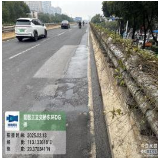
图 2-25 东环DG桥0#台右侧桥面积水
