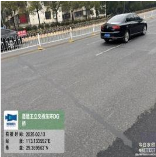
图 2-3 东环 DG 桥桥面铺装层多处开裂
