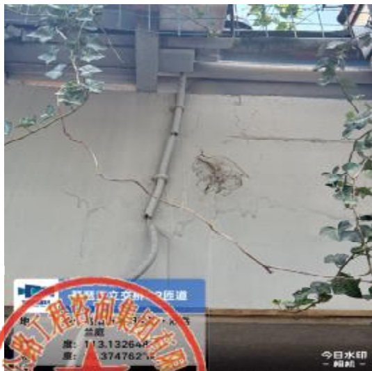
图 2-35 C2匝道桥护栏开裂破损
