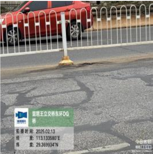
图 2-4 东环DG桥桥面铺装层多处开裂、磨光露骨
