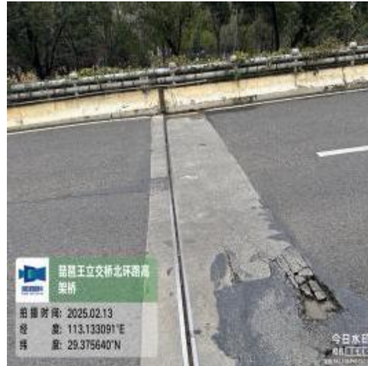
图 2-18 BG高架桥3#伸缩缝处锚固区开裂、止水带破损、泥沙堵塞
