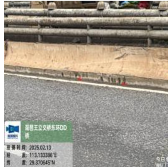
图 2-37 东环DD桥左侧砼护栏漏筋锈蚀
