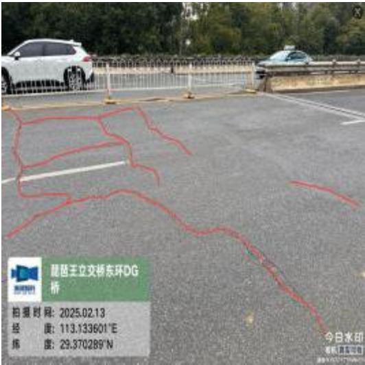
图 2-3 东环 DG 桥桥面铺装层多处开裂
