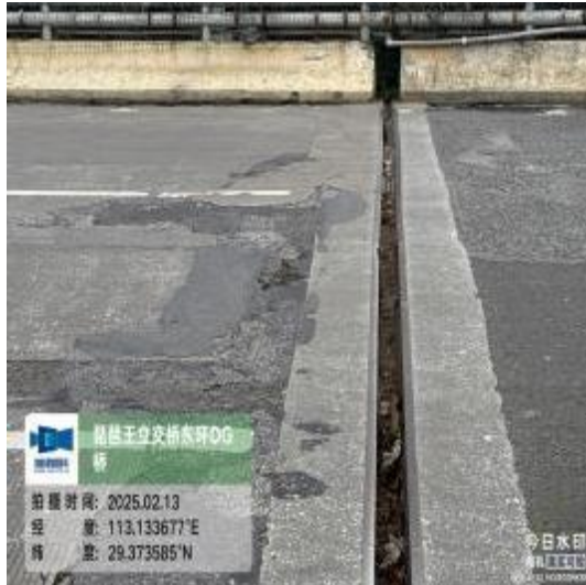
图 2-17 东环DG桥2#伸缩缝处止水带破损、锚固区开裂
