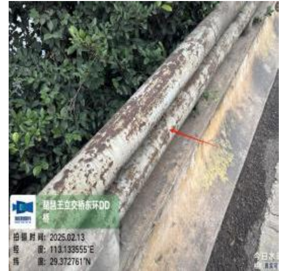
图 2-38 东环DD桥右侧钢质护栏锈蚀
