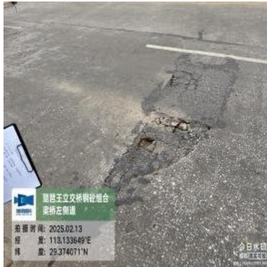
图 2-8 钢砼组合梁桥桥面铺装破损
