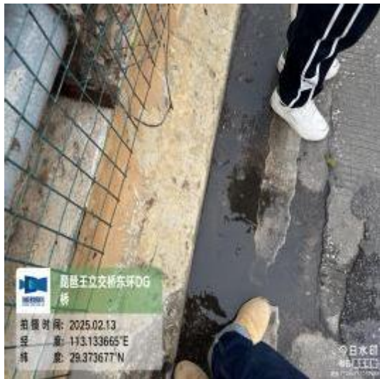
图 2-27 钢砼组合梁桥桥面积水
