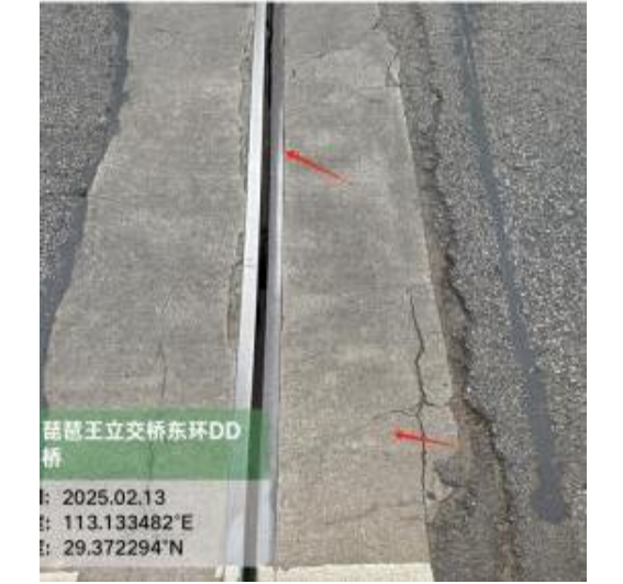
图 2-24 伸缩缝止水带破损、锚固区开裂破损
