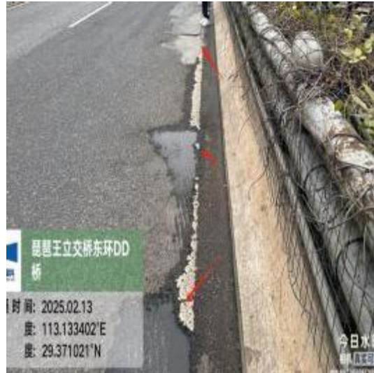
图 2-13 桥面铺装层多处坑槽
