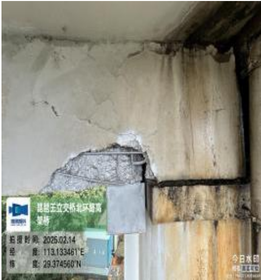
图 2-39 BG高架桥 21#梁左侧腹板在21#墩处破损露筋
