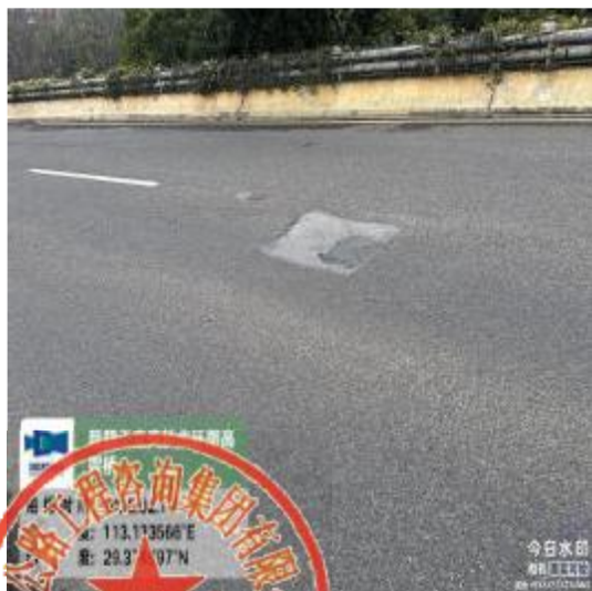
图 2-11 BG高架桥桥面铺装层多处坑槽
