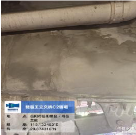
图 2-42 1#梁体在1#墩右腹板存在破损开裂
