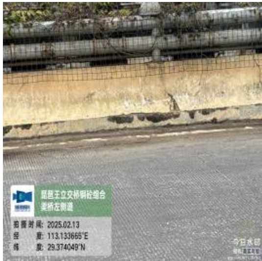
图 2-33 钢砼组合梁桥两侧钢质护栏破损、锈蚀
