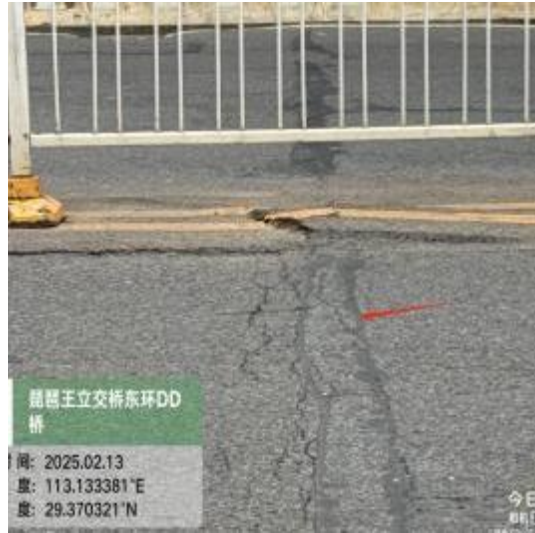
图 2-14 桥面铺装层局部网裂
