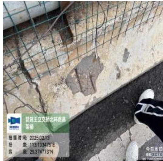
图 2-34 BG高架桥两侧砼护栏锈蚀、开裂、破损
