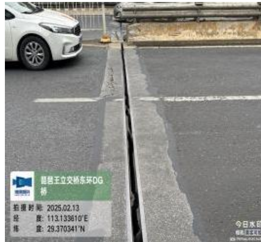
图 2-16 东环DG桥1#伸缩缝处锚固区网裂
