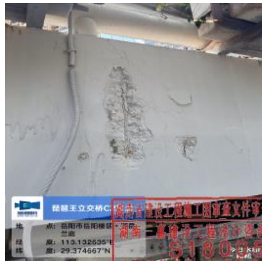
图 2-36 C2匝道桥砼护栏露筋
