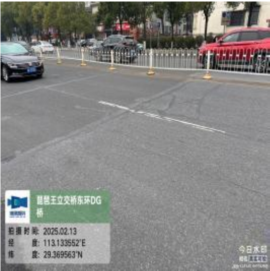
图 2-4 东环DG桥桥面铺装层多处开裂、磨光露骨
