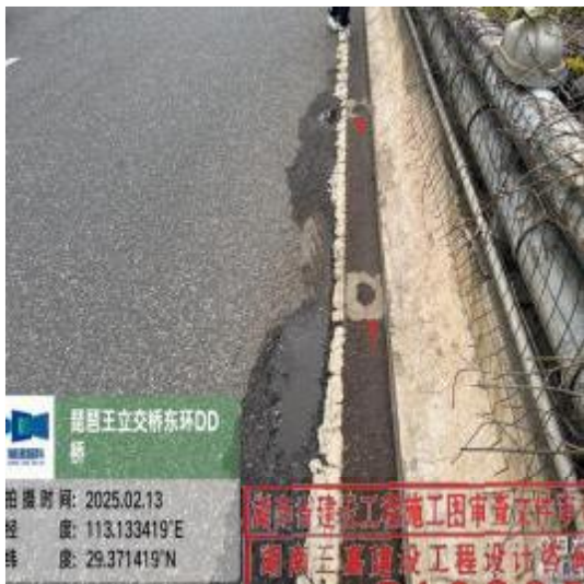
图 2-28 钢砼组合梁桥桥面泄水孔堵塞
