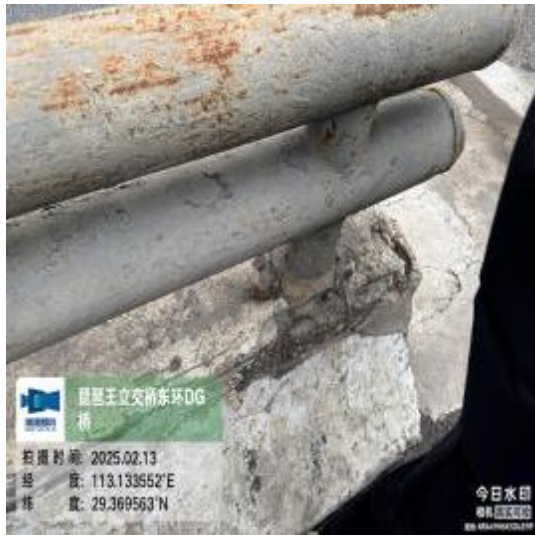
图 2-31 东环DG桥0#台右侧钢质护栏锈蚀，砼护栏破损
