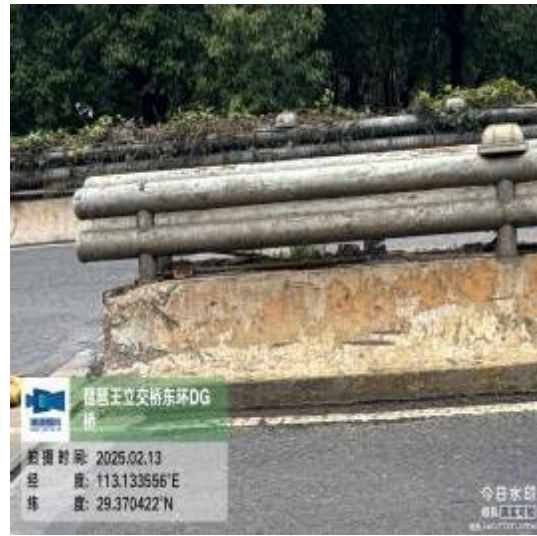
图 2-32 东环DG桥左侧钢质栏杆锈蚀、破损、露筋
