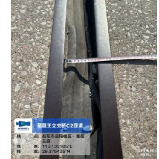
图 2-23 C2匝道桥8#墩伸缩缝缝宽异常
