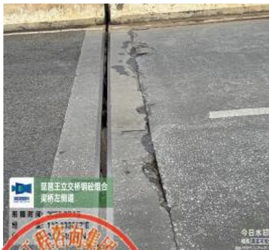
图 2-19 BG高架桥4#伸缩缝止水带破损、泥沙堵塞
