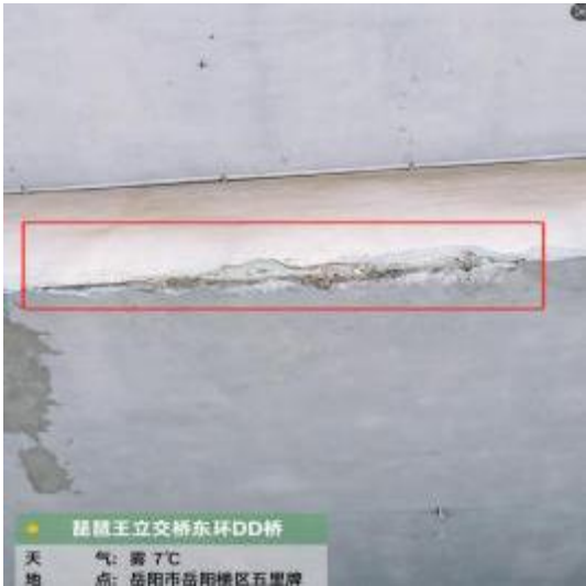
图 2-43 梁体右侧存在破损
