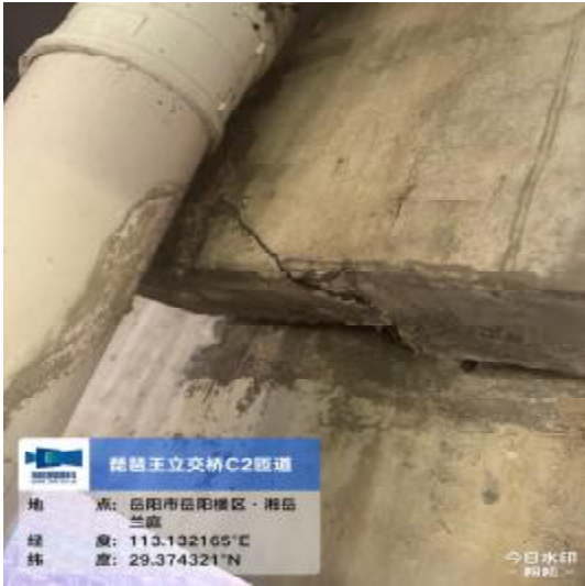
图 2-41 1#梁体在1#墩右腹板存在破损开裂
