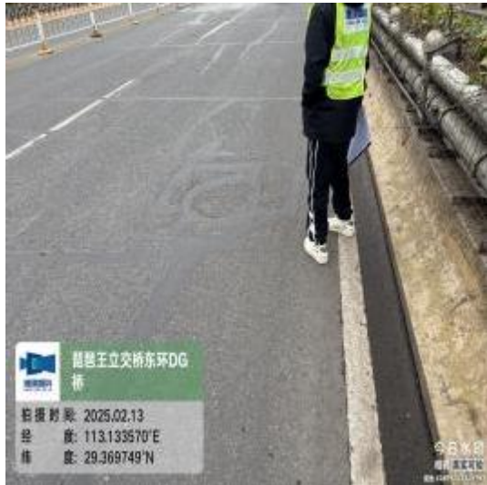
图 2-7 东环 DG 桥桥面铺装层坑槽
