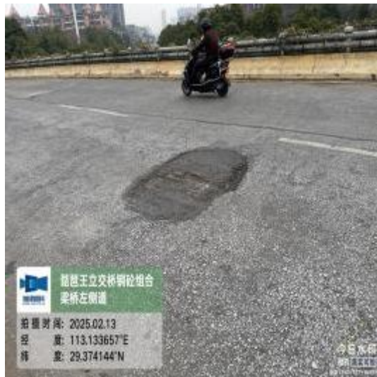
图 2-10 钢砼组合梁桥桥面铺装层坑槽
