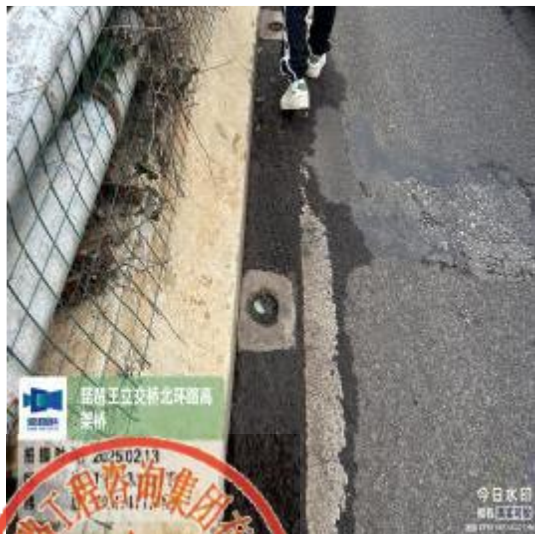
图 2-27 钢砼组合梁桥桥面积水
