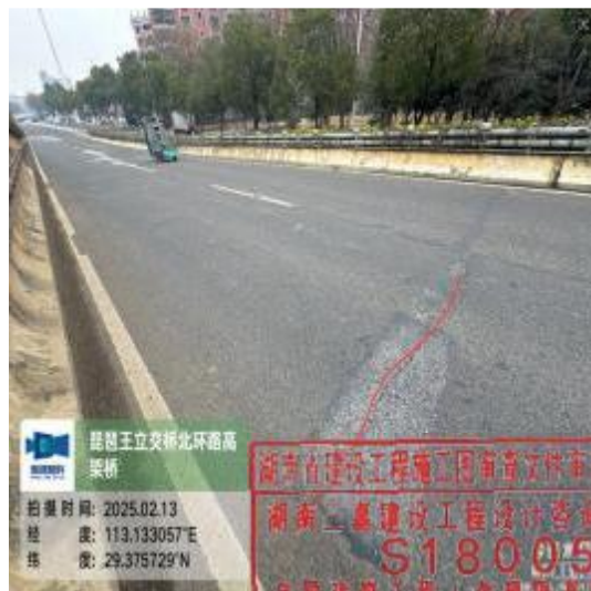
图 2-12 BG高架桥桥面铺装层多处开裂
