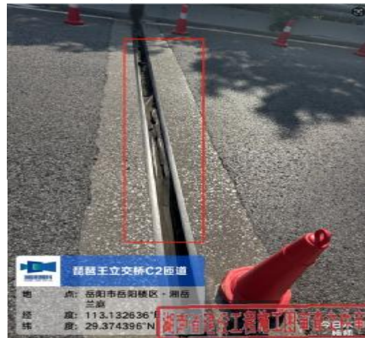
图 2-18 BG高架桥3#伸缩缝处锚固区开裂、止水带破损、泥沙堵塞
