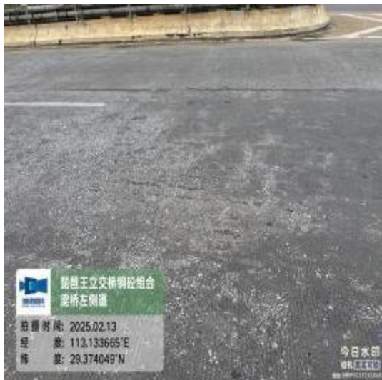
图 2-9 钢砼组合梁桥桥面铺装层磨光、露骨
