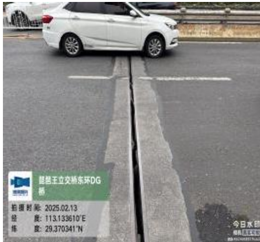
图 2-15 东环DG桥1#伸缩缝处止水带破损
