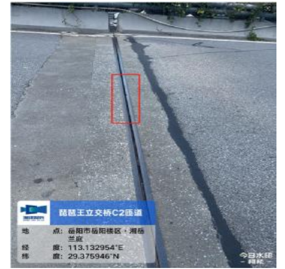
图 2-22 C2匝道桥12#台伸缩缝止水带破损
