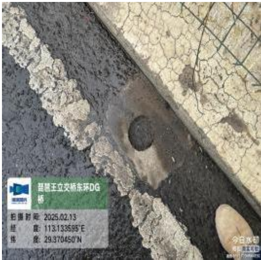
图 2-26 东环DG桥泄水孔堵塞
