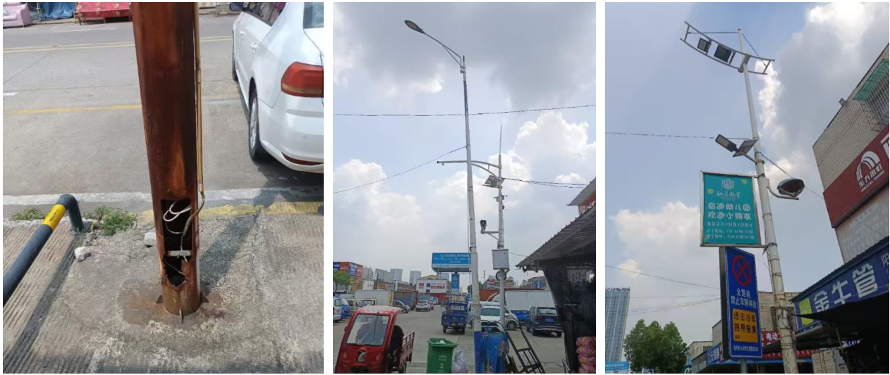
图 8-1 灯具损坏 灯杆倾斜 原市电无法点亮加装太阳能路灯
