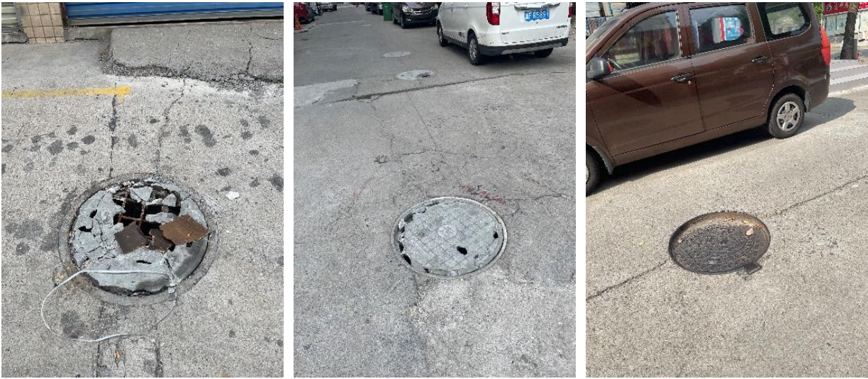
图 4-32 市场内部现状井盖破损沉降
