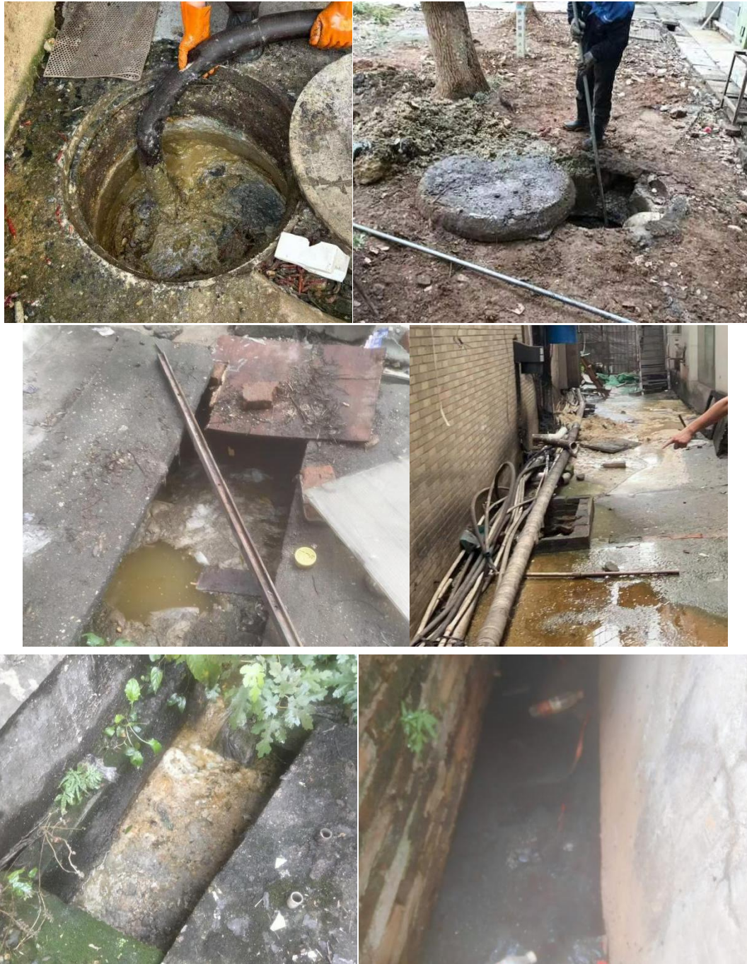
管网及排水沟渠淤积堵塞现状图片
