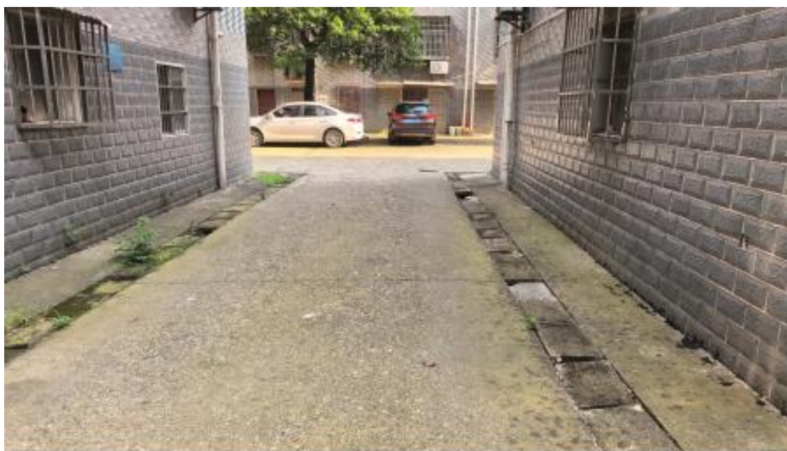
排水沟盖板破损（2）
