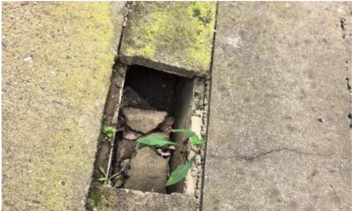
排水沟盖板破损 (4)
