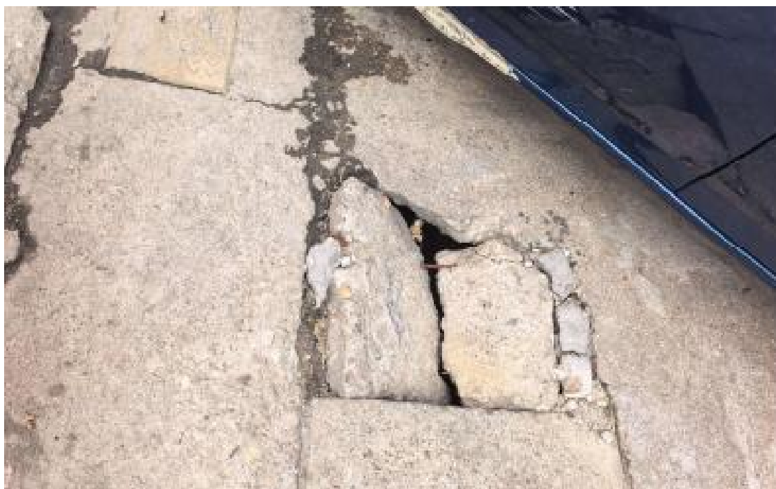
排水沟盖板破损（1）
