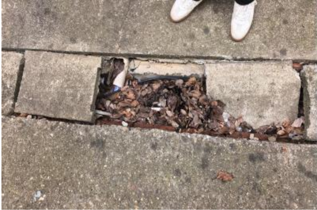
排水沟盖板破损 (3)
