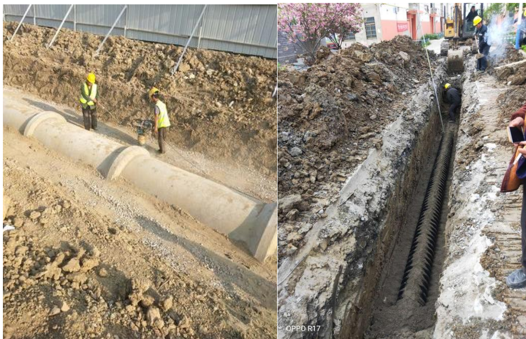
沟槽回填示意图
