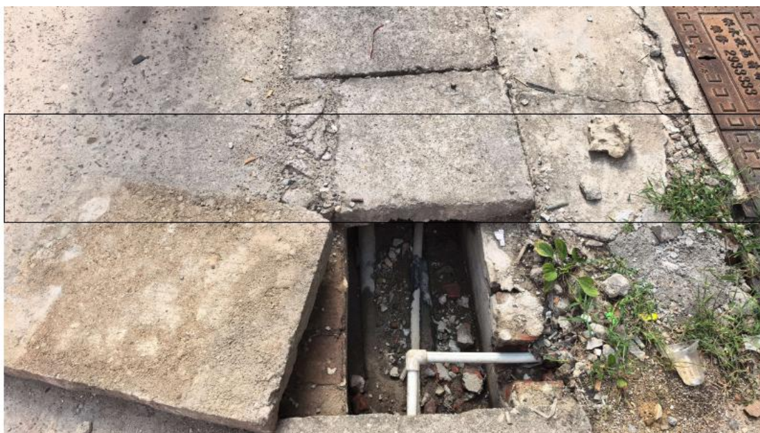
排水沟内布设给水、电力管线，导致沟内淤堵
